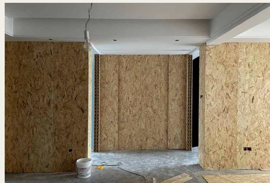
壁体(OSB面材)の施工
